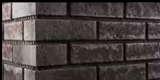
Вид готового шва. Всегда полностью расшиваются все стороны.
