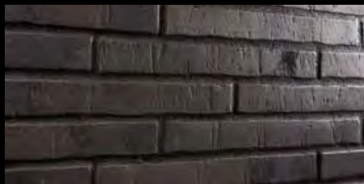
Готовый вид шва.
