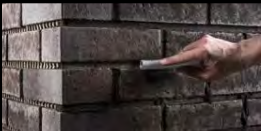
При расшивке швов кельмой можно выработать различные оптические элементы. Будь-то заглубленная затирка или шов, выполненный кельмой, который, как в данном случае, легко вжимается или вытягивается с помощью шланга.
