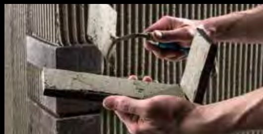
С уголками работают по методу двойного намазывания.
