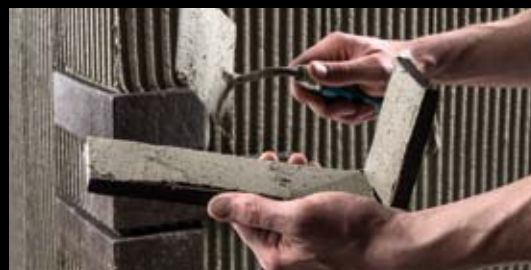
С уголками работают по методу двойного намазывания.
