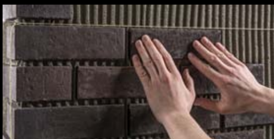
Укладка плоских клинкерных плиток с помощью шнура. Клинкерные плитки вдавливаются в слой клея.
