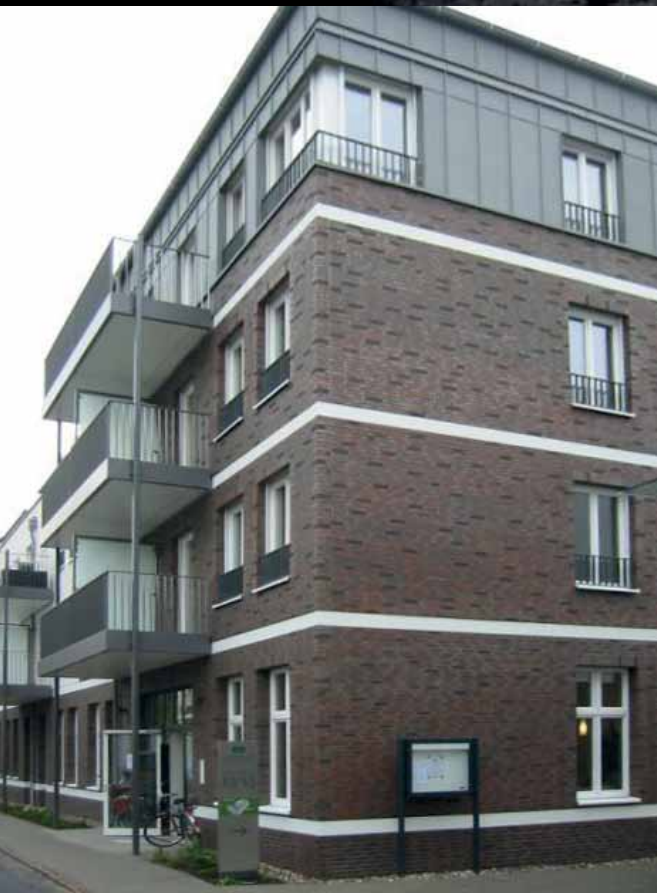
Abb. Die hier nach dem Duo-Prinzip verlegte Fläche zeigt die Feldhaus | baro-Oberfläche mit ca. 30-prozentigem Anteil
